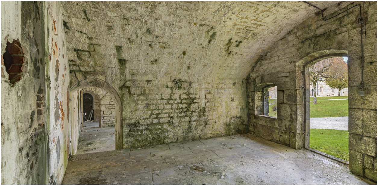
Fort Saint-André : pièce casematée.
