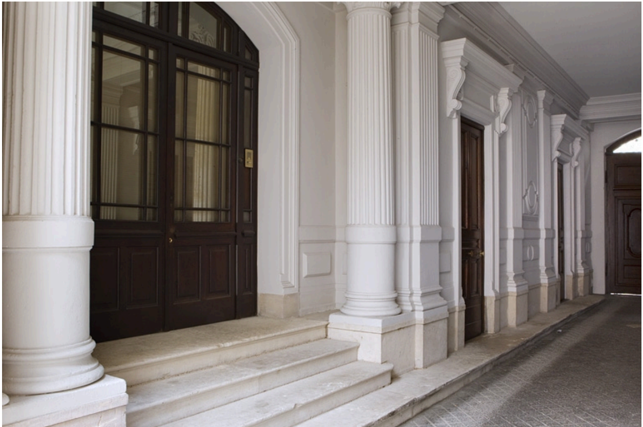
Passage cocher :détail du mur droit.
