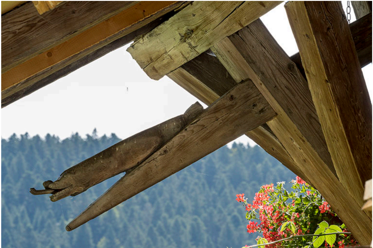
Ferme, façade latérale droite : 1er arbalétrier (à gauche) sculpté en forme de serpent.
