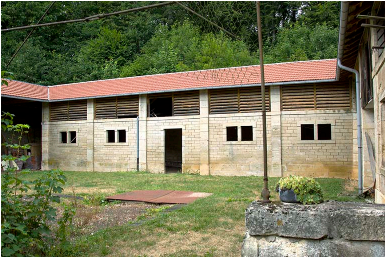
Vue générale de la bergerie, aile nord-ouest.
