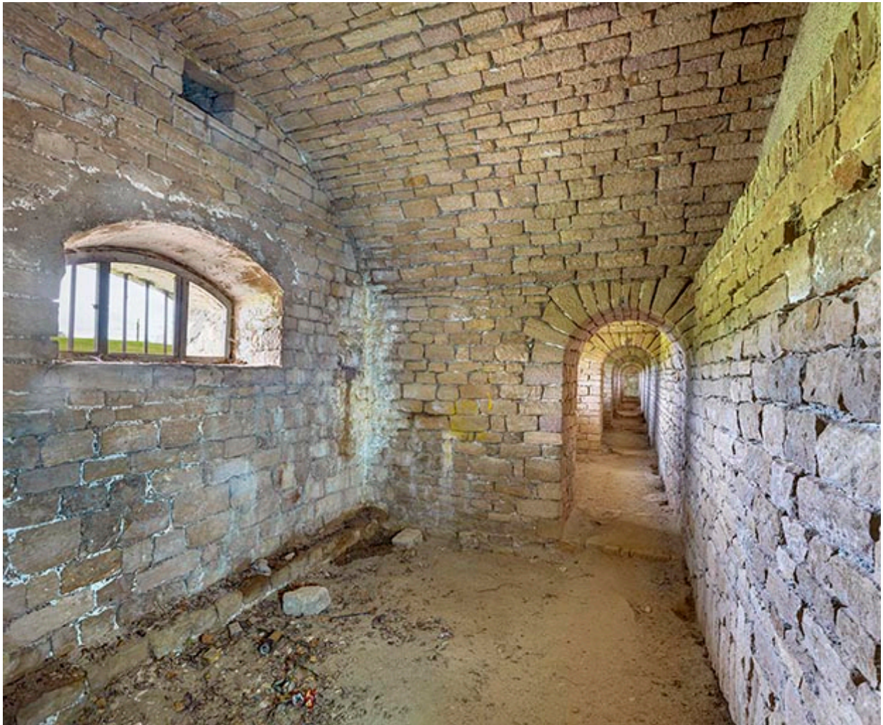
Galerie intérieure de la courtine.
