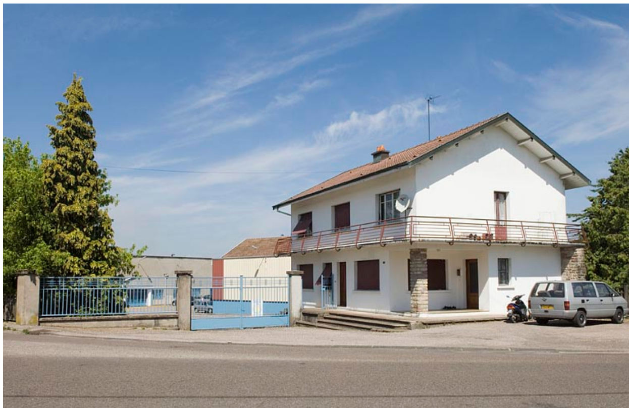
Ancien accès de l'usine et conciergerie.
