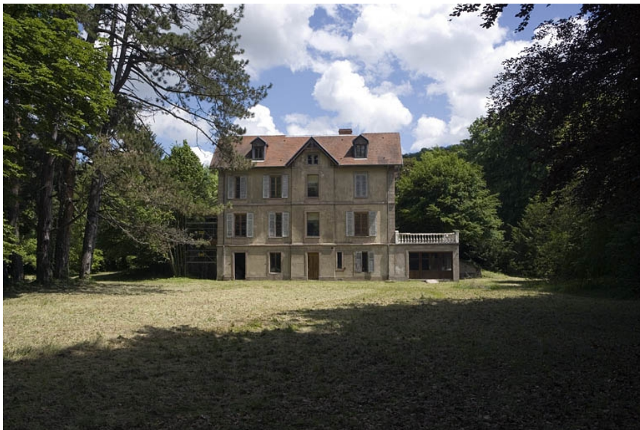
Logement patronal. Façade postérieure.
