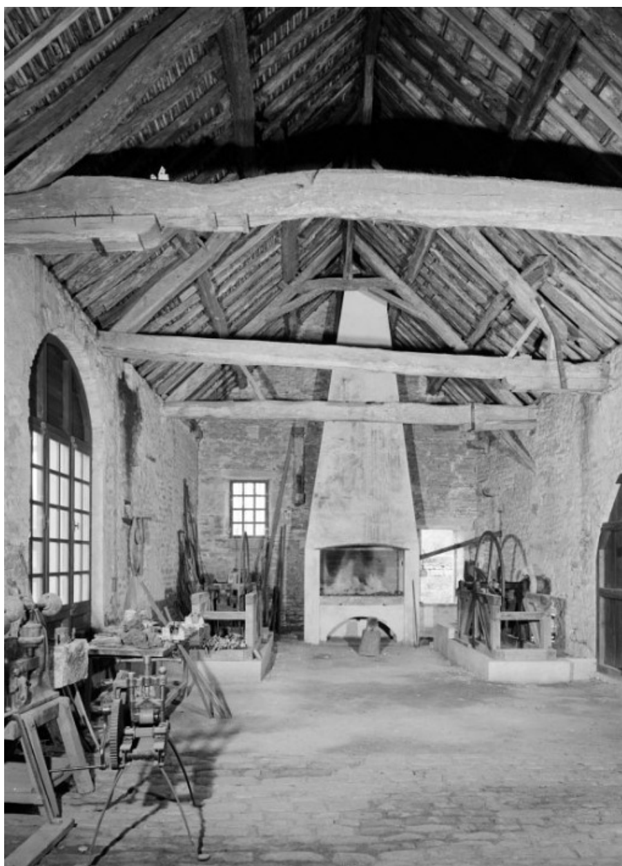
Bâtiment de la fenderie, vue intérieure prise du sud.
