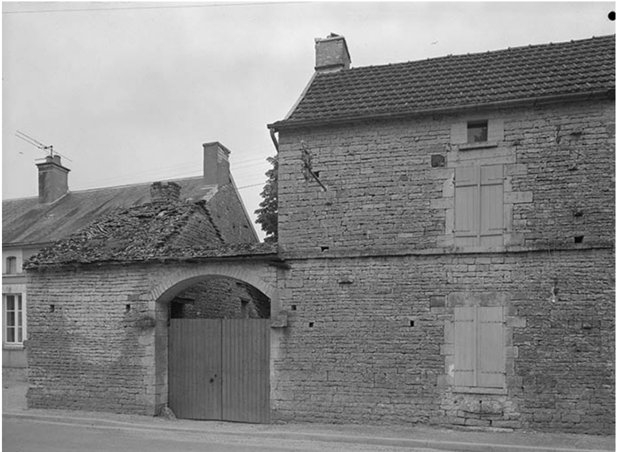
Maison et portail. Façades sur rue.
