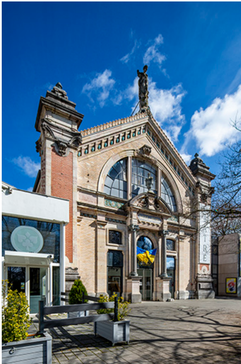
Façade principale, vue de trois quarts.
