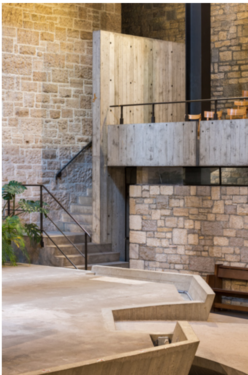
Escalier d'accès à la tribune est.
