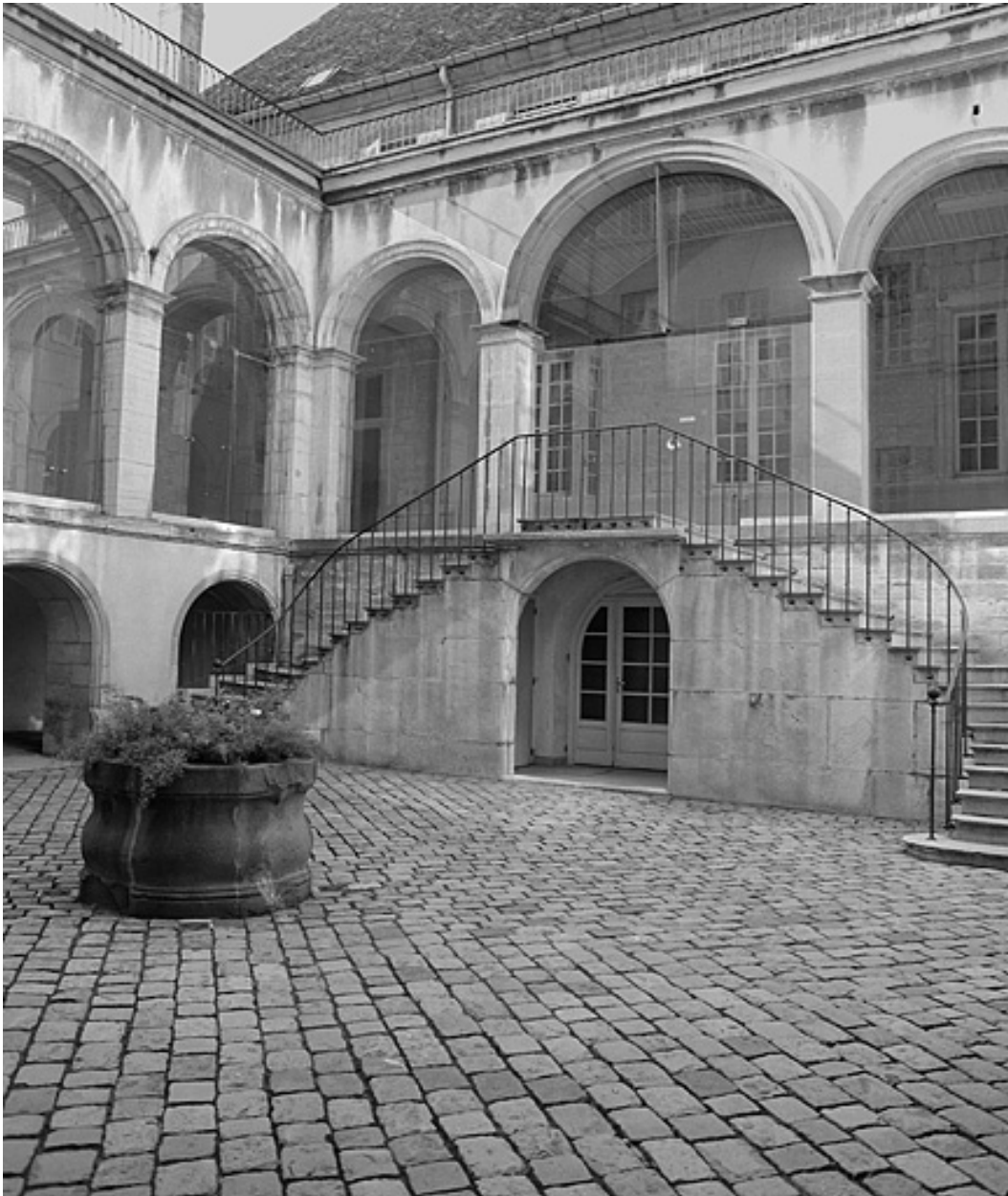
Cour intérieure : vue générale.
