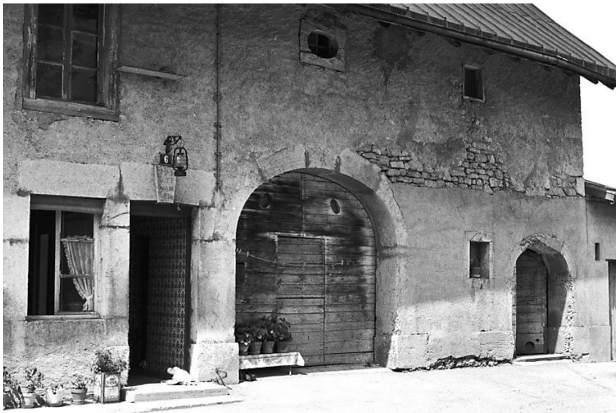
Façade antérieure : vue rapprochée.
