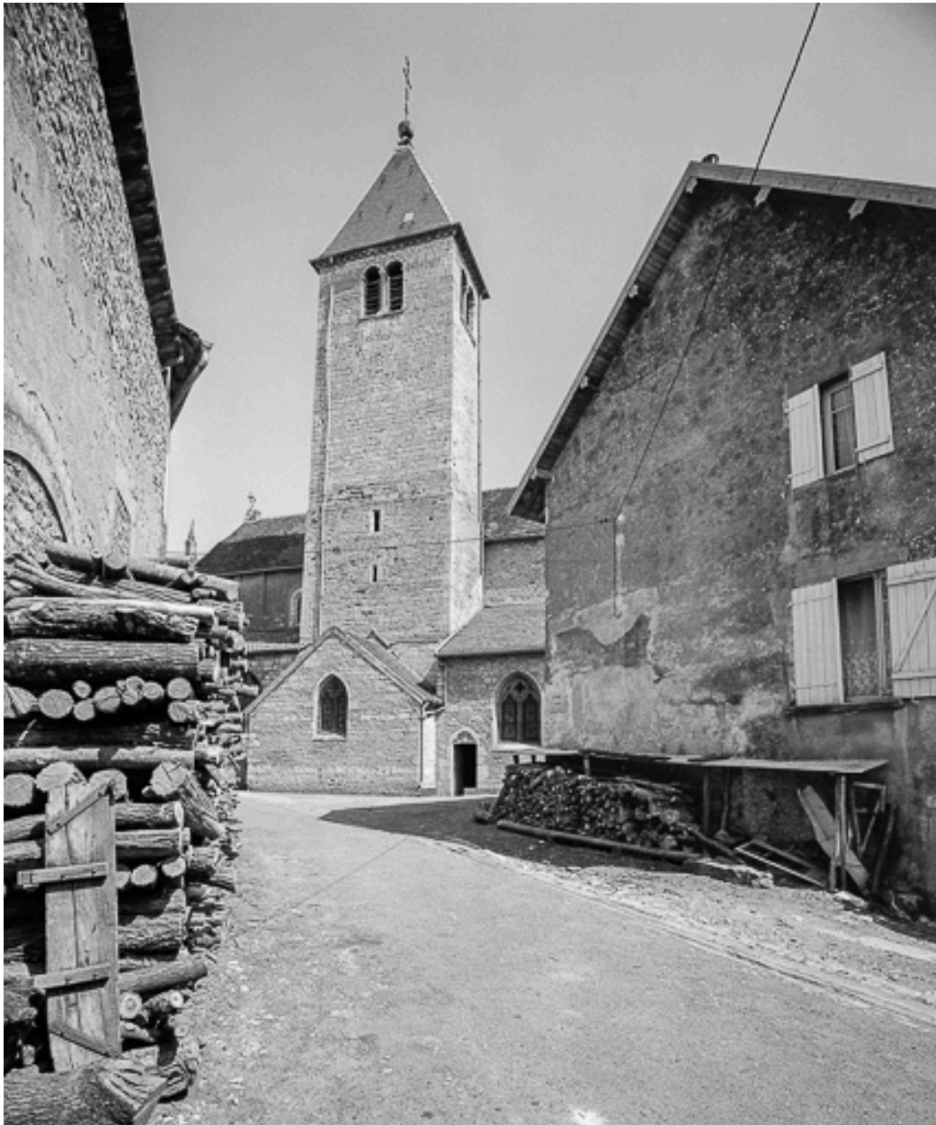
Façade latérale droite.
