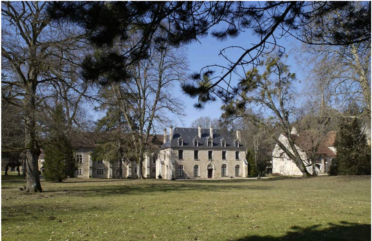
Bâtiments conventuels : vue d'ensemble depuis l'est.
