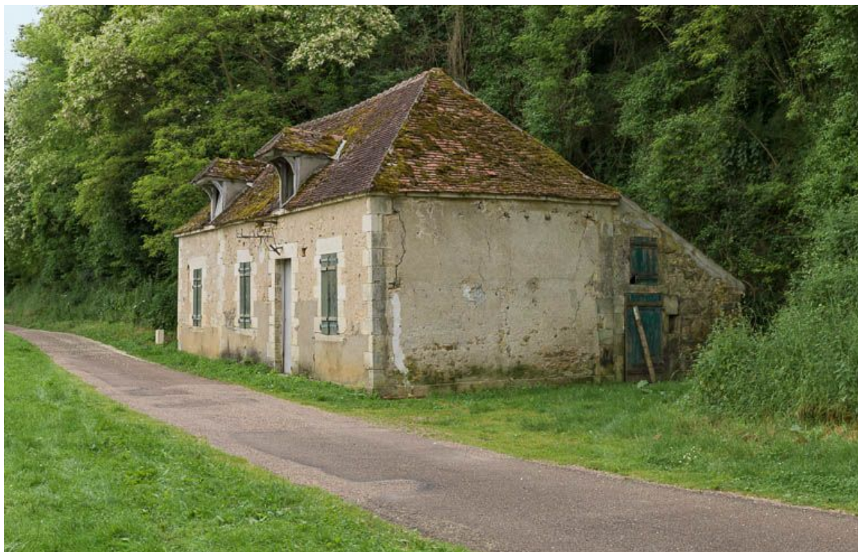
Vue de 3/4 de la maison éclusière.
