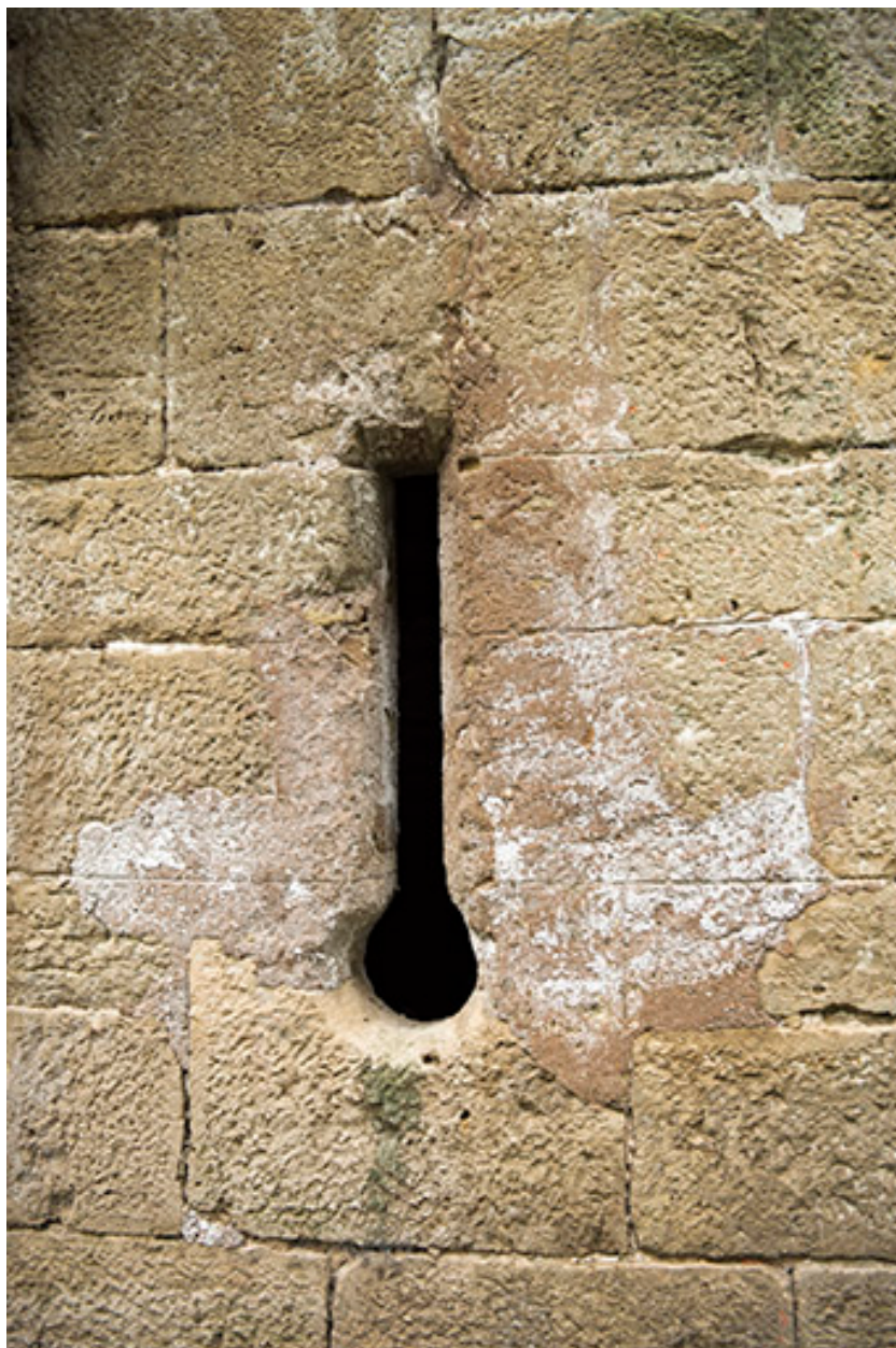
Tour ouest : vue extérieure de la canonnière.
