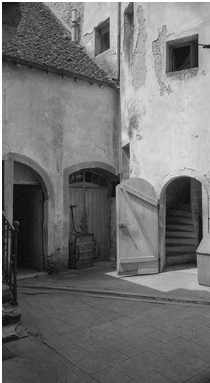
Batiments dans la cour intérieure.
