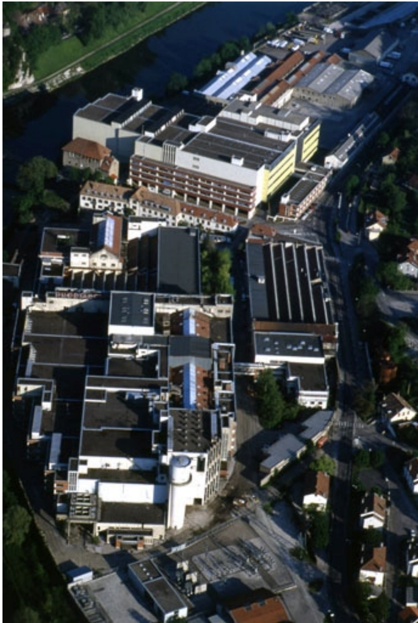
Vue aérienne des usines A et B depuis l'est.
