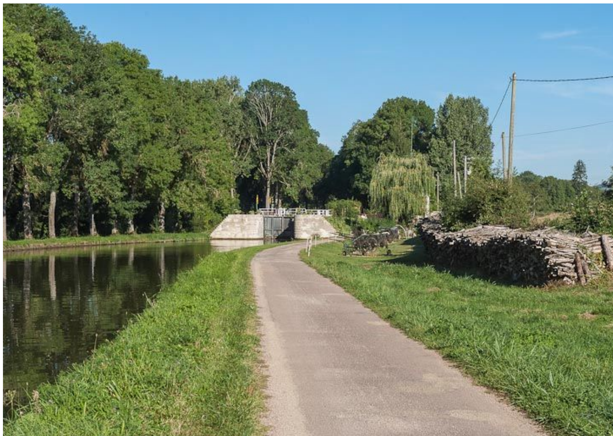
Vue de l'écluse depuis l'aval.
