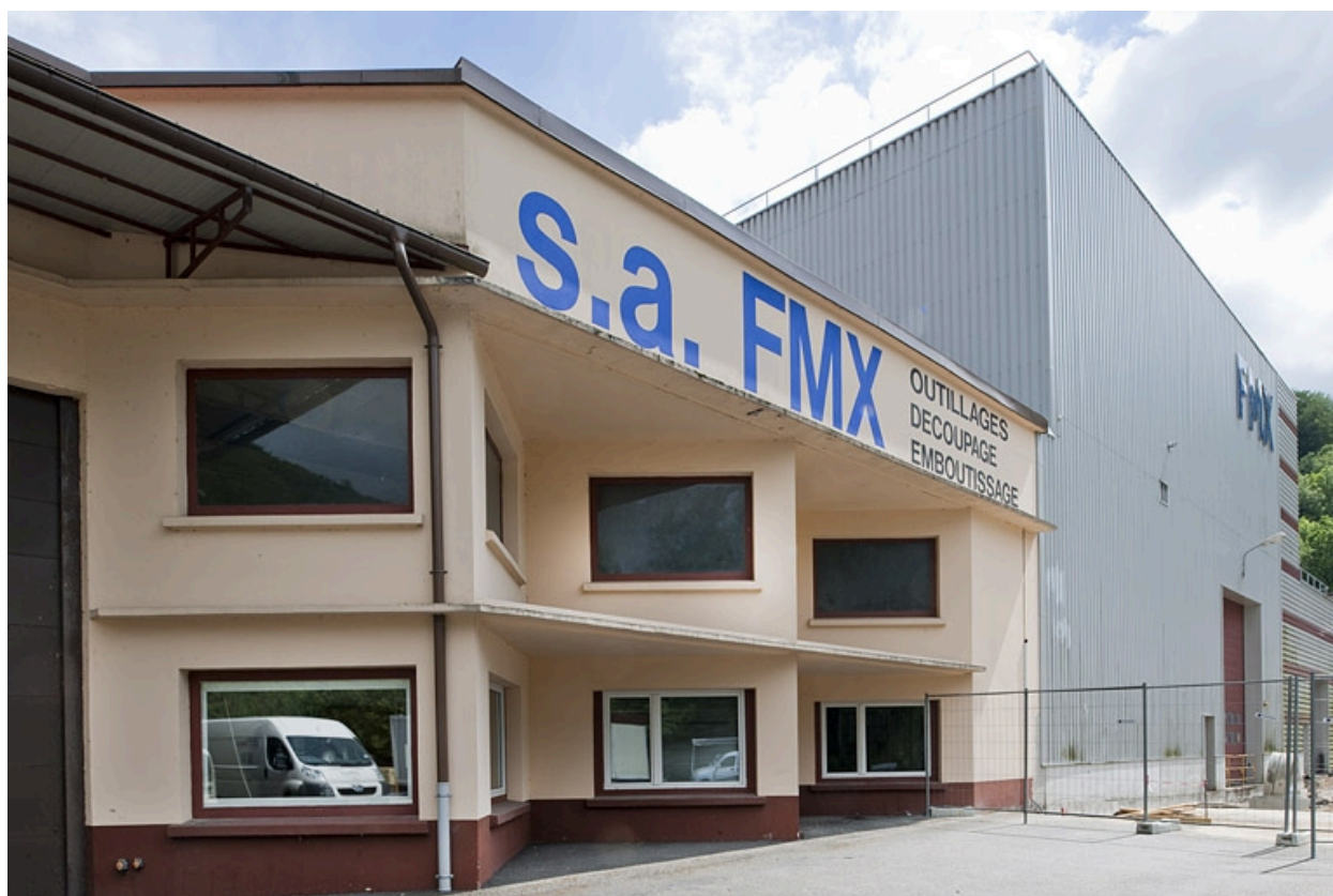
Façade nord : le nouvel atelier des presses.
