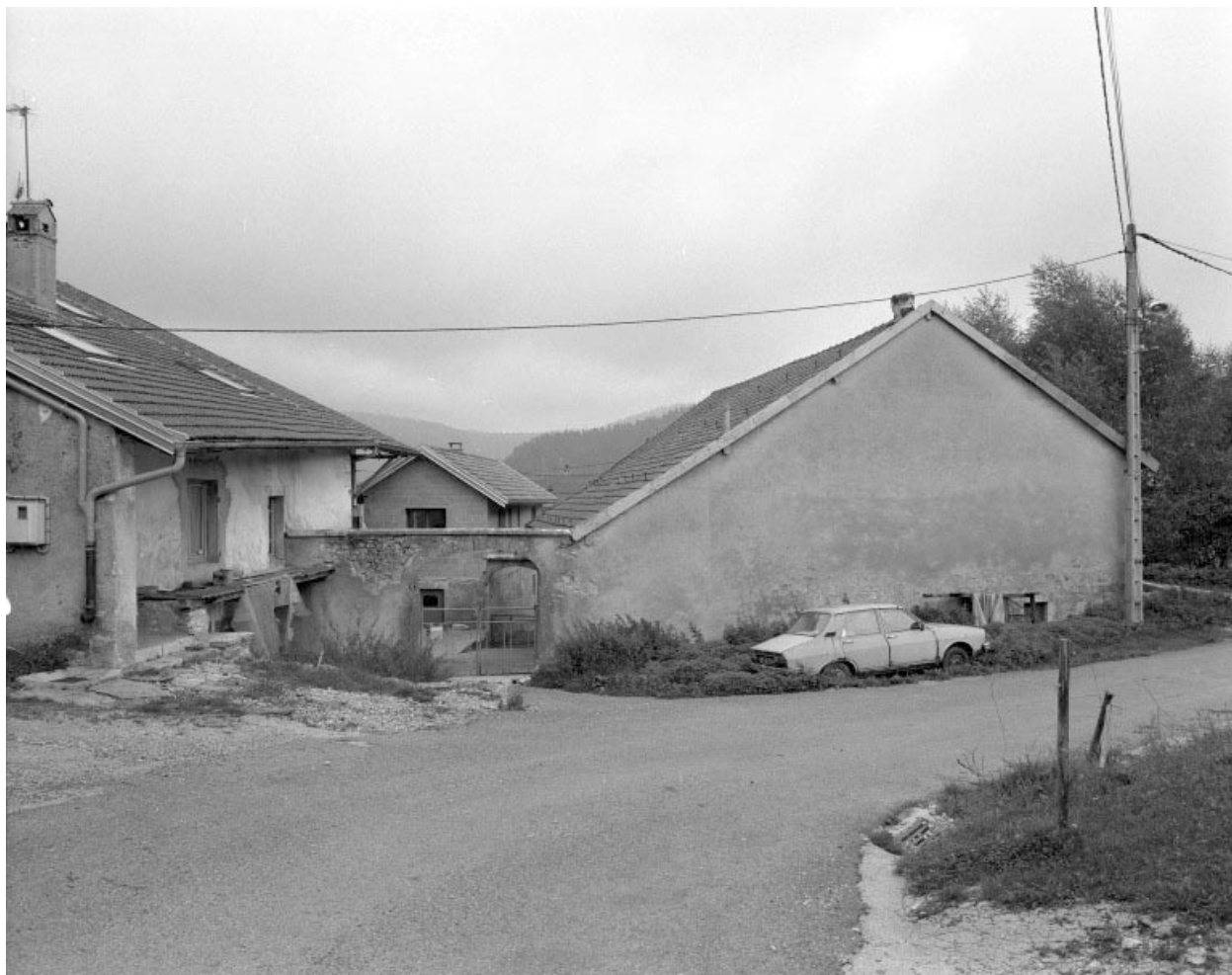
Vue générale de l'accès à la maison.
