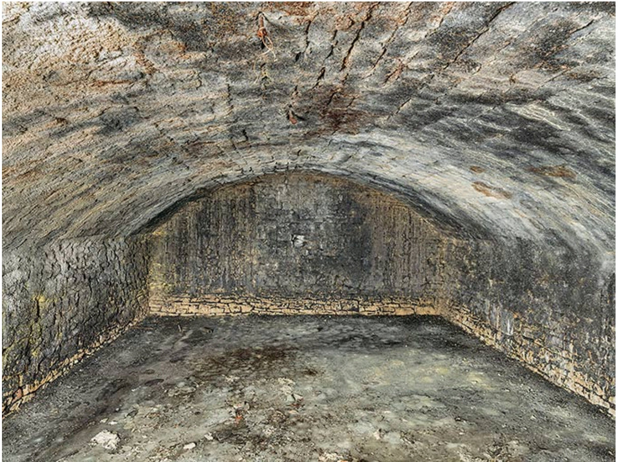
Autre casemate du niveau inférieur.
