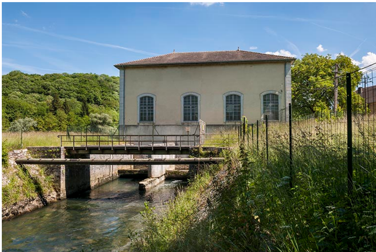
La centrale hydroélectrique et son canal de fuite.
