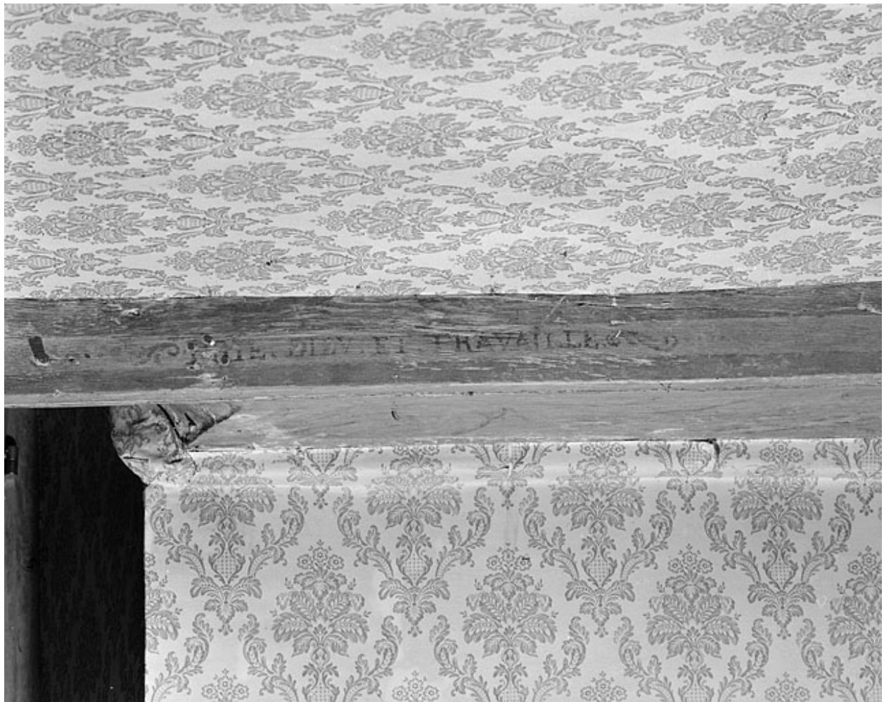
Premier corps de bâtiment. Plafond du rez-de-chaussée.
