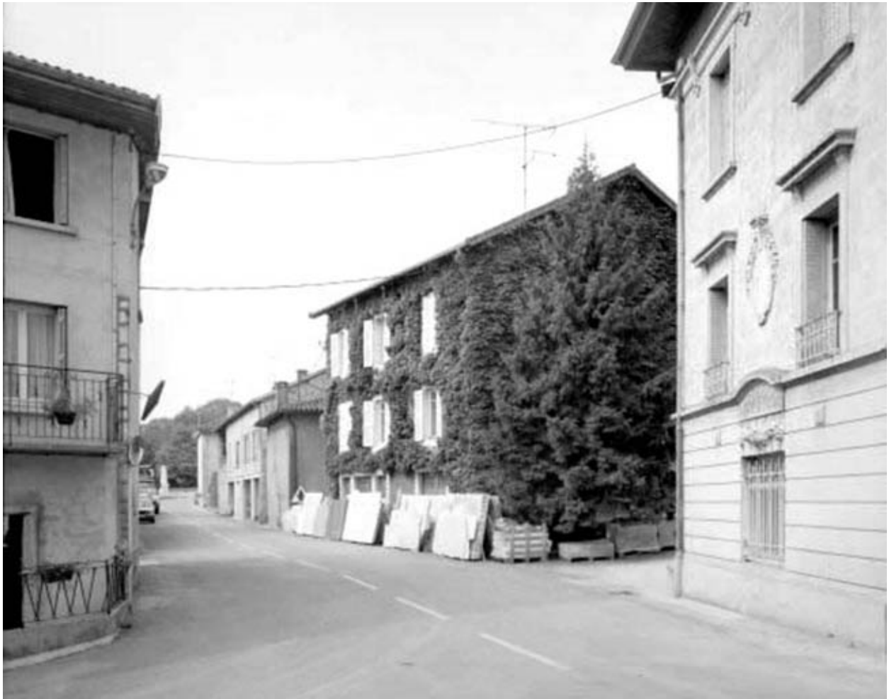
Logement patronal et logement d'ouvriers.
