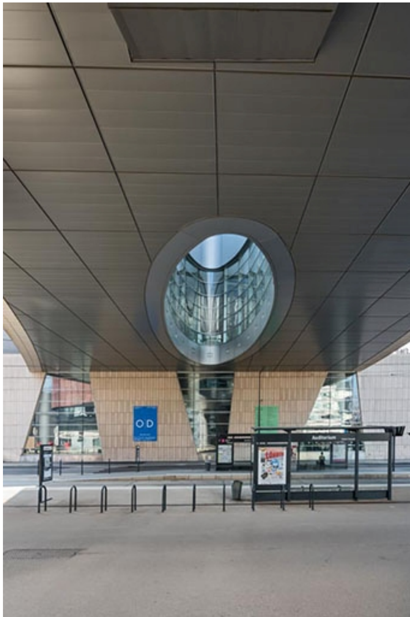
Intrados du corps d'entrée sur le boulevard de Champagne.
