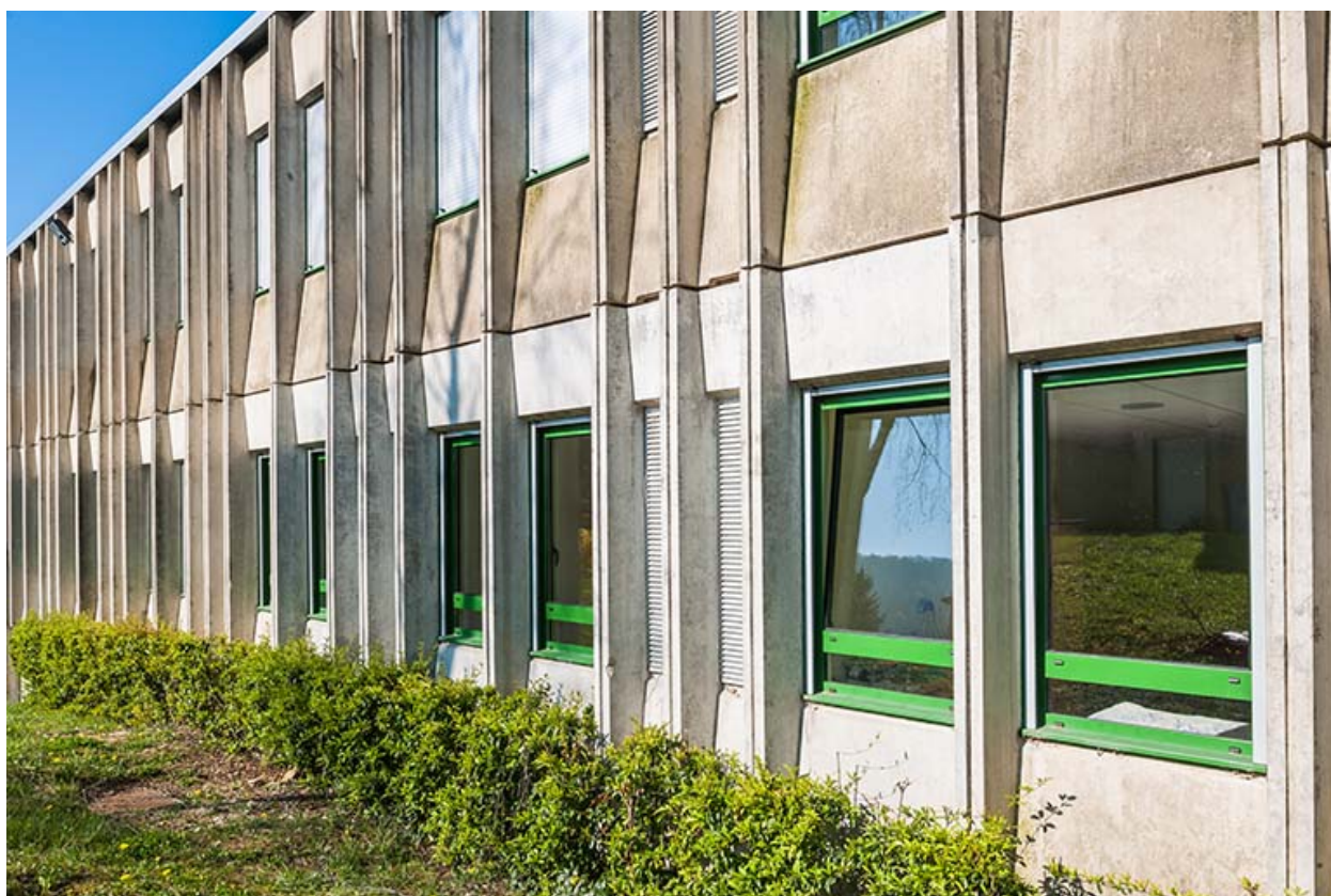
Façades préfabriquées : détail.
