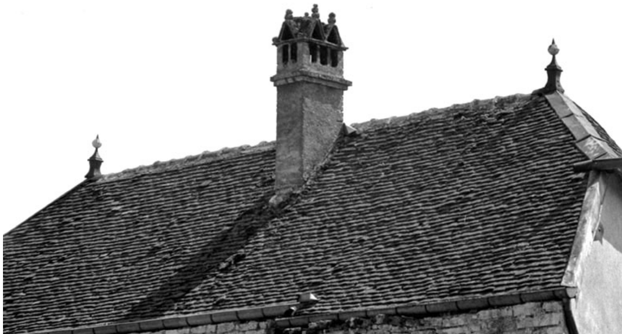
Motey-Besuche, ferme située rue du Crotot : détail du toit recouvert de tuiles plates.
