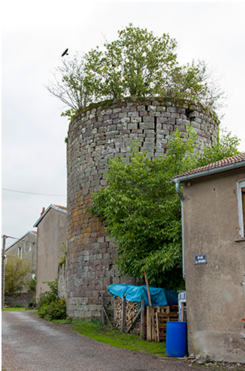
L'ancienne tour d'entrée de ville.
