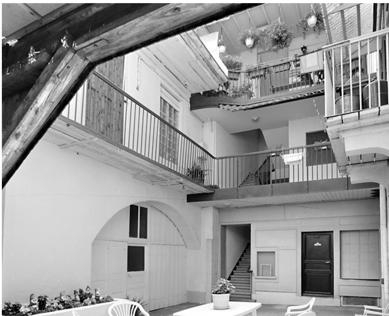
Cour et escalier.
