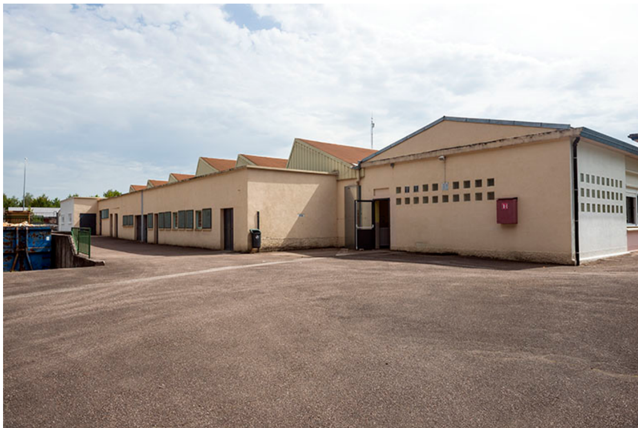
Ateliers : vue générale.
