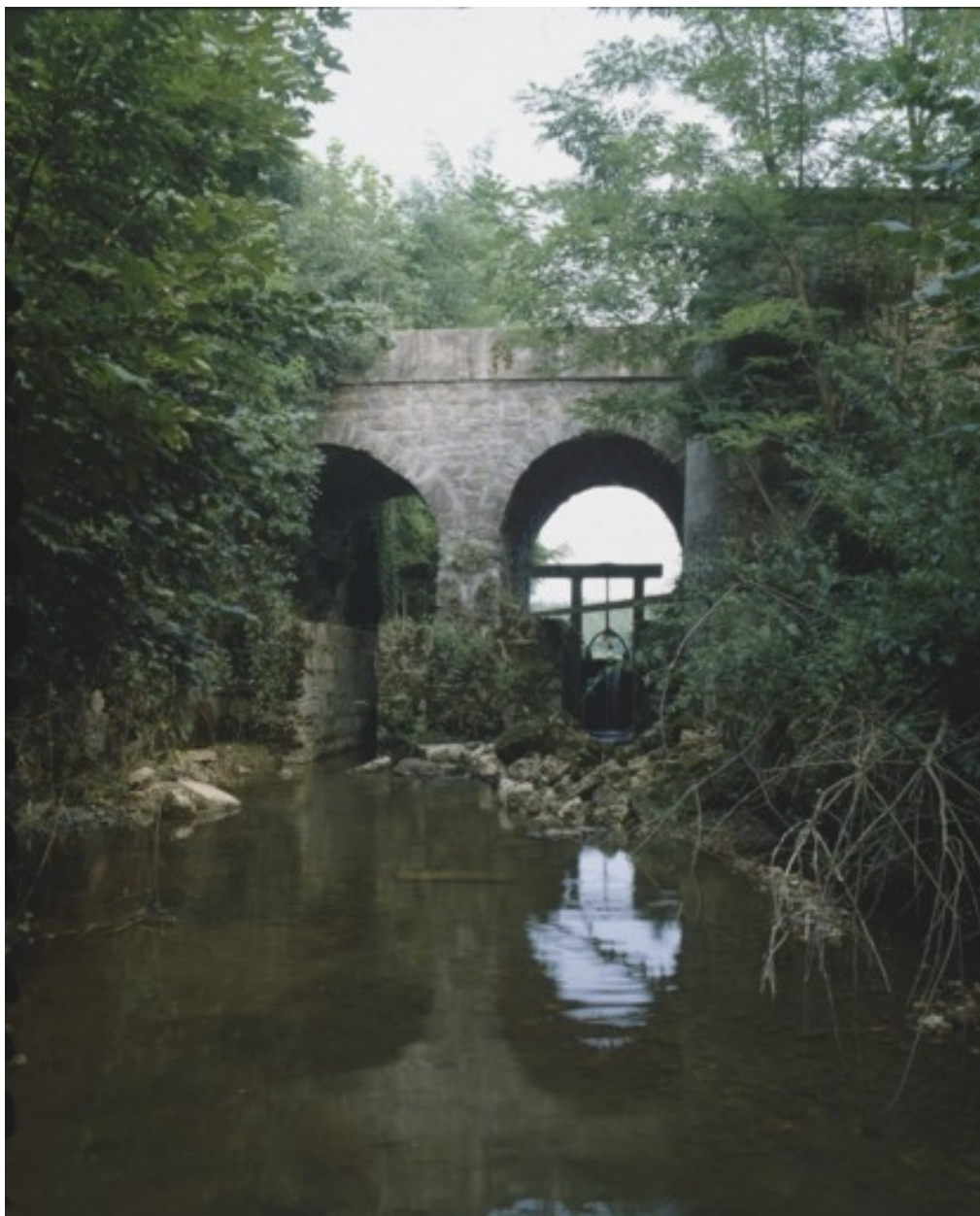
Canal de décharge en 1989.
