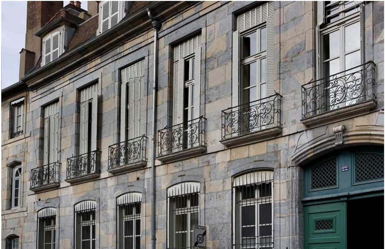
Façade sur rue : détail des baies du premier étage.
