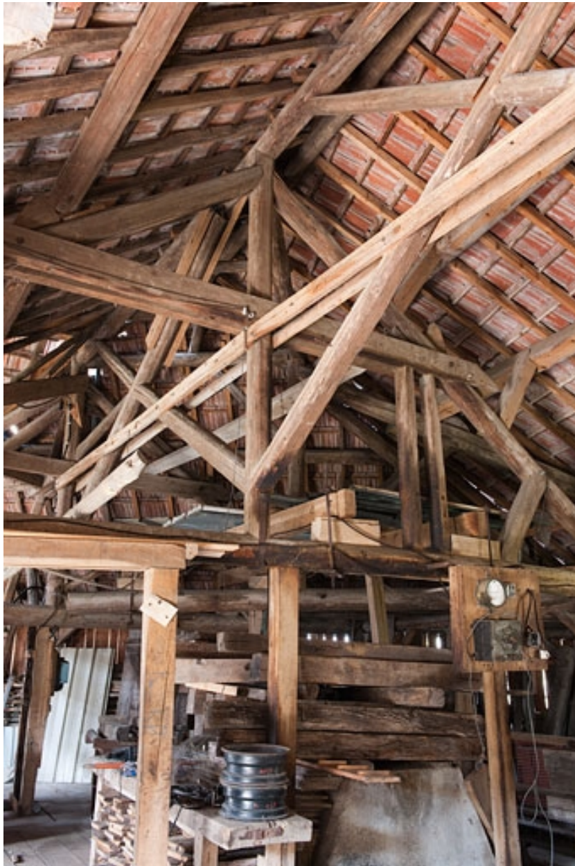
Scierie Courtot, rue du Pont : charpente.
