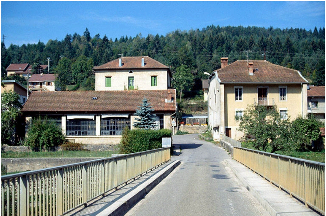
Vue d'ensemble depuis le pont.
