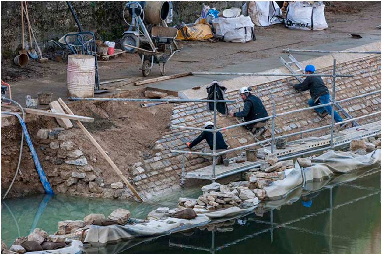
Réfection du perré du chemin de halage en aval du moulin Saint-Paul : ouvriers refaisant le parement.
