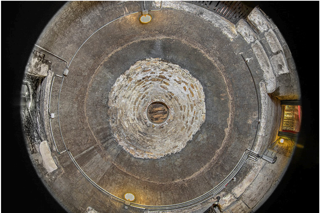
Plafond du niveau inférieur.
