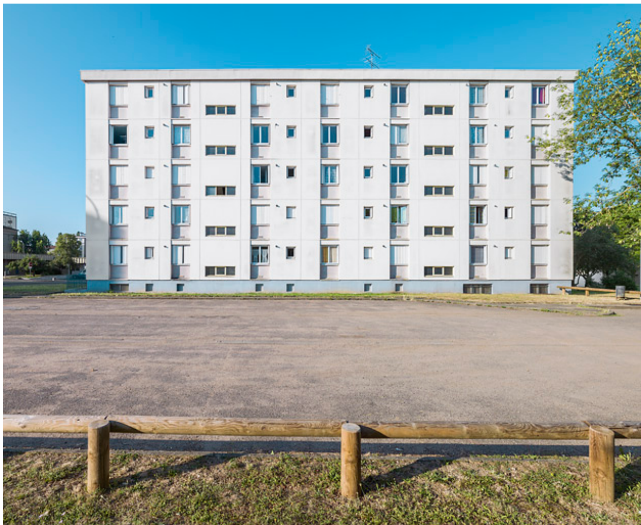
Bâtiment B-1, façade postérieure nord.
