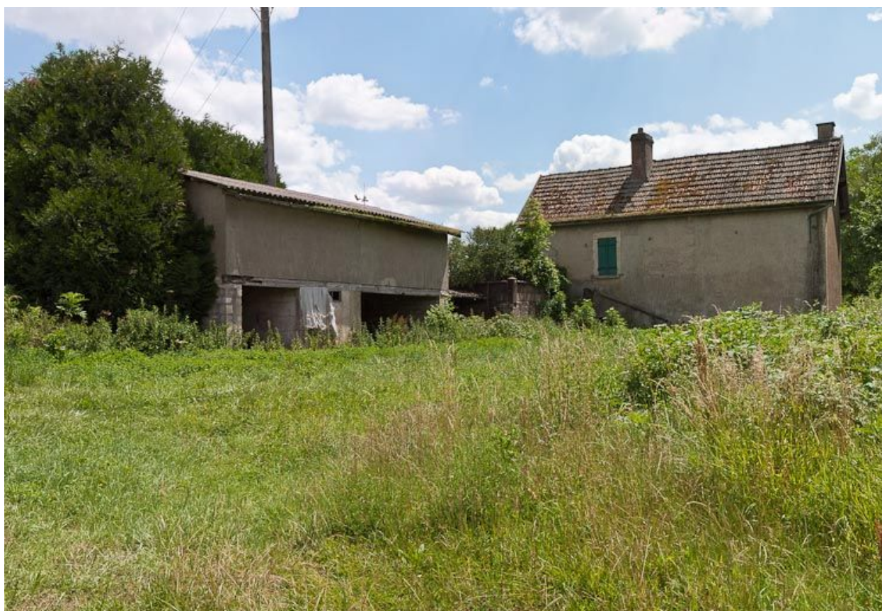
Vue du jardin et des annexes du site d'écluse.
