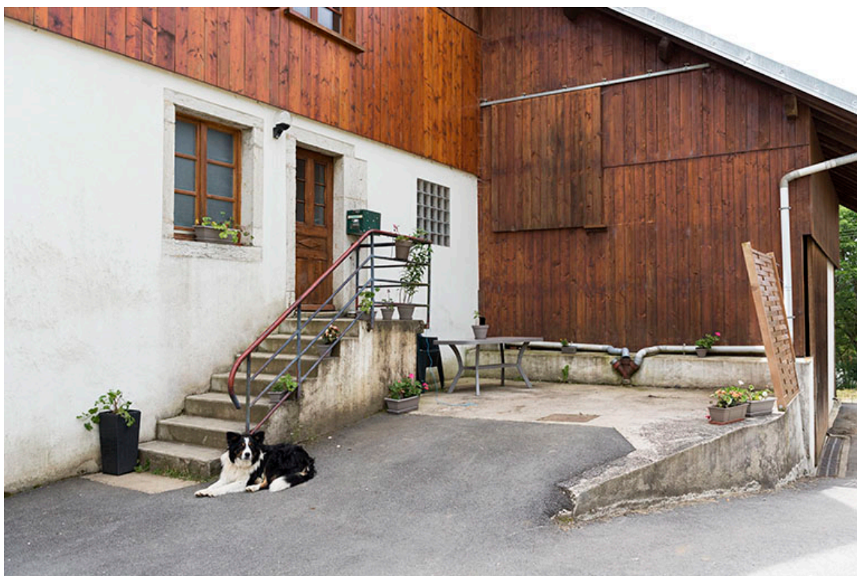
Façade latérale droite : escalier extérieur et étable.
