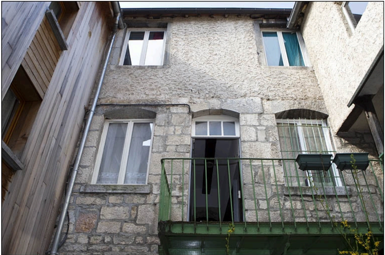
Façade antérieure du logis secondaire : vue d'ensemble depuis le premier étage.
