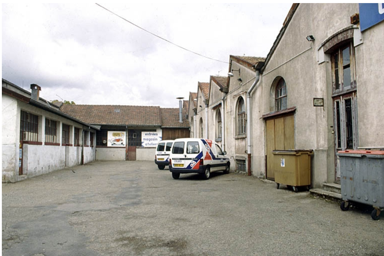
Vue des ateliers depuis la cour.
