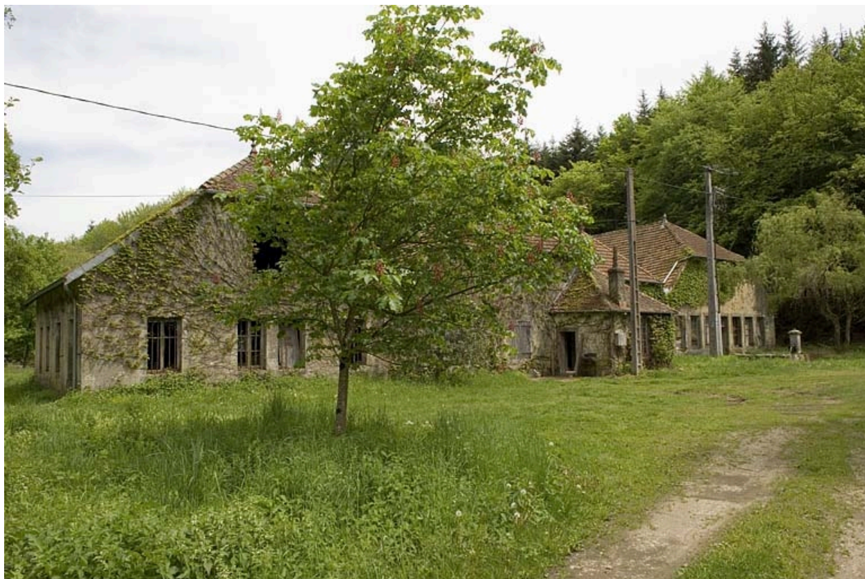
Façades antérieures depuis l'ouest.
