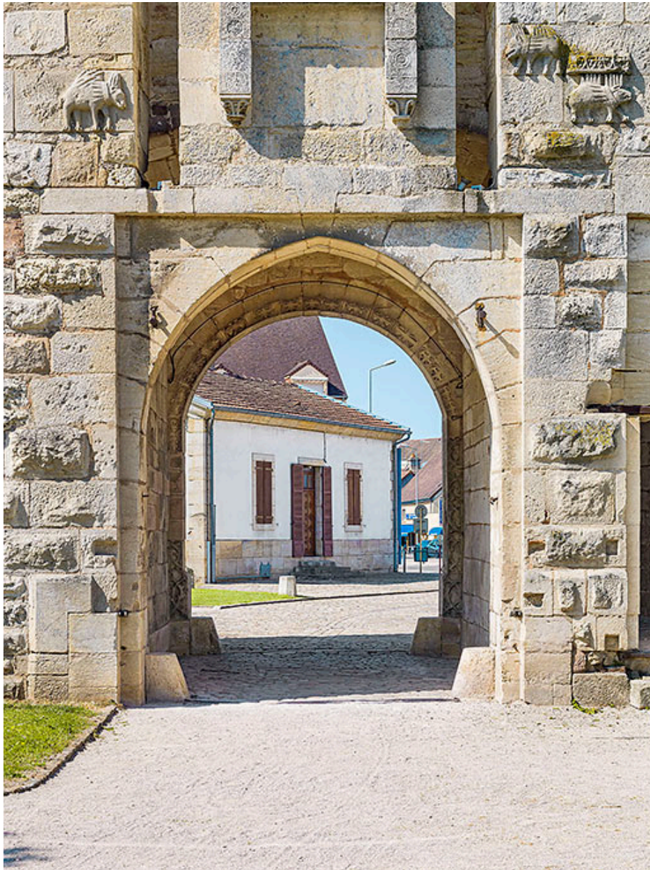
Le passage voûté de la porte.
