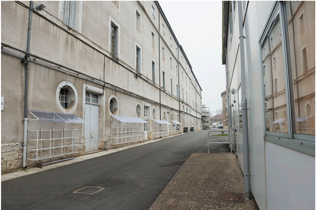
Façade nord-est sur cour de l'ancienne caserne, vue le long du préfabriqué.
