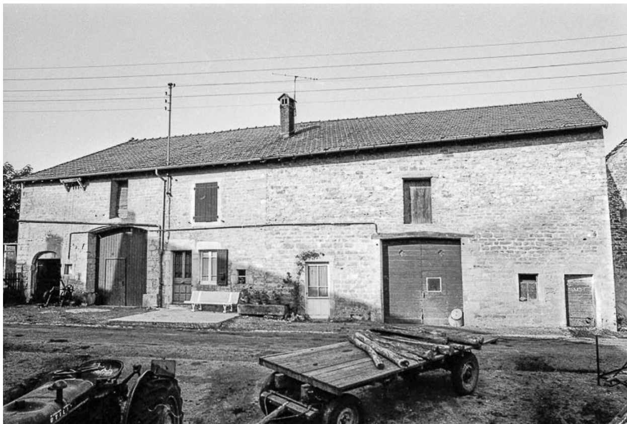
Ferme cadastrée A3 204 : façade antérieure.
