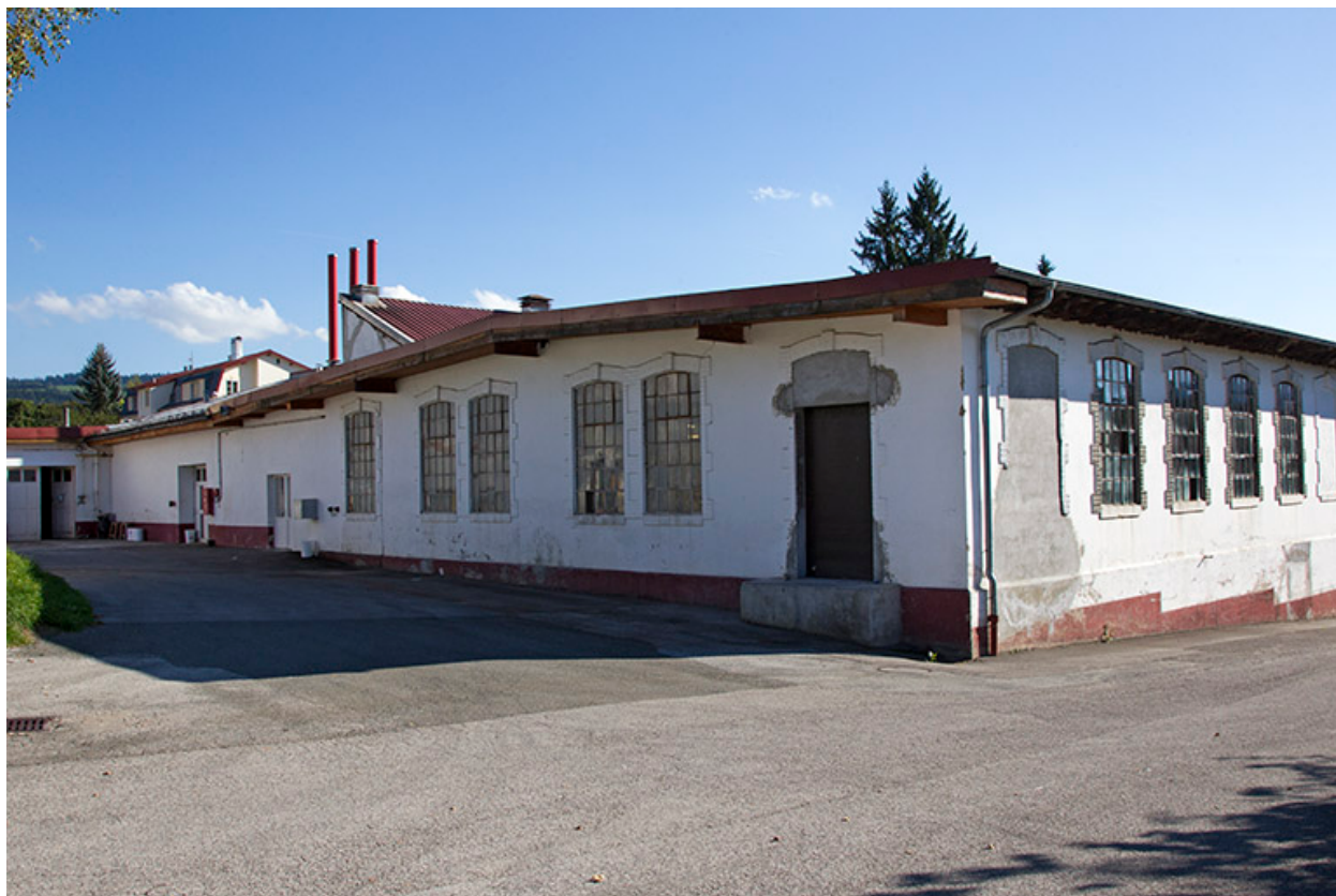
Bâtiments sud : façades postérieure et latérale droite.
