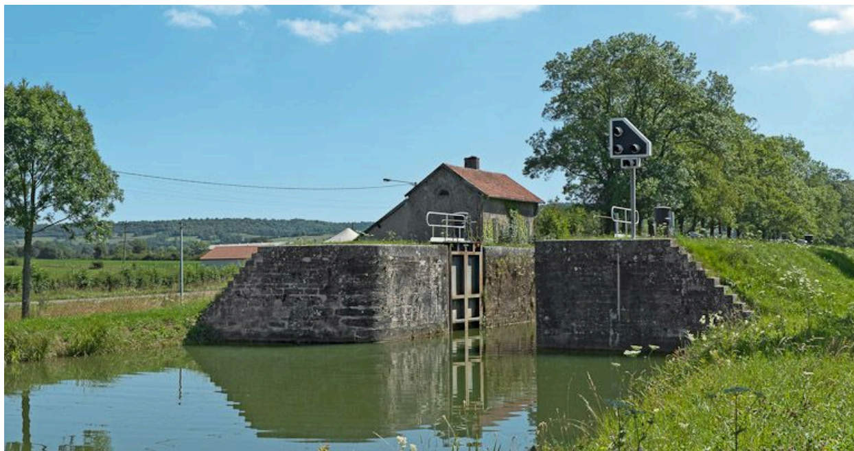
Vue du site d'écluse depuis l'aval.
