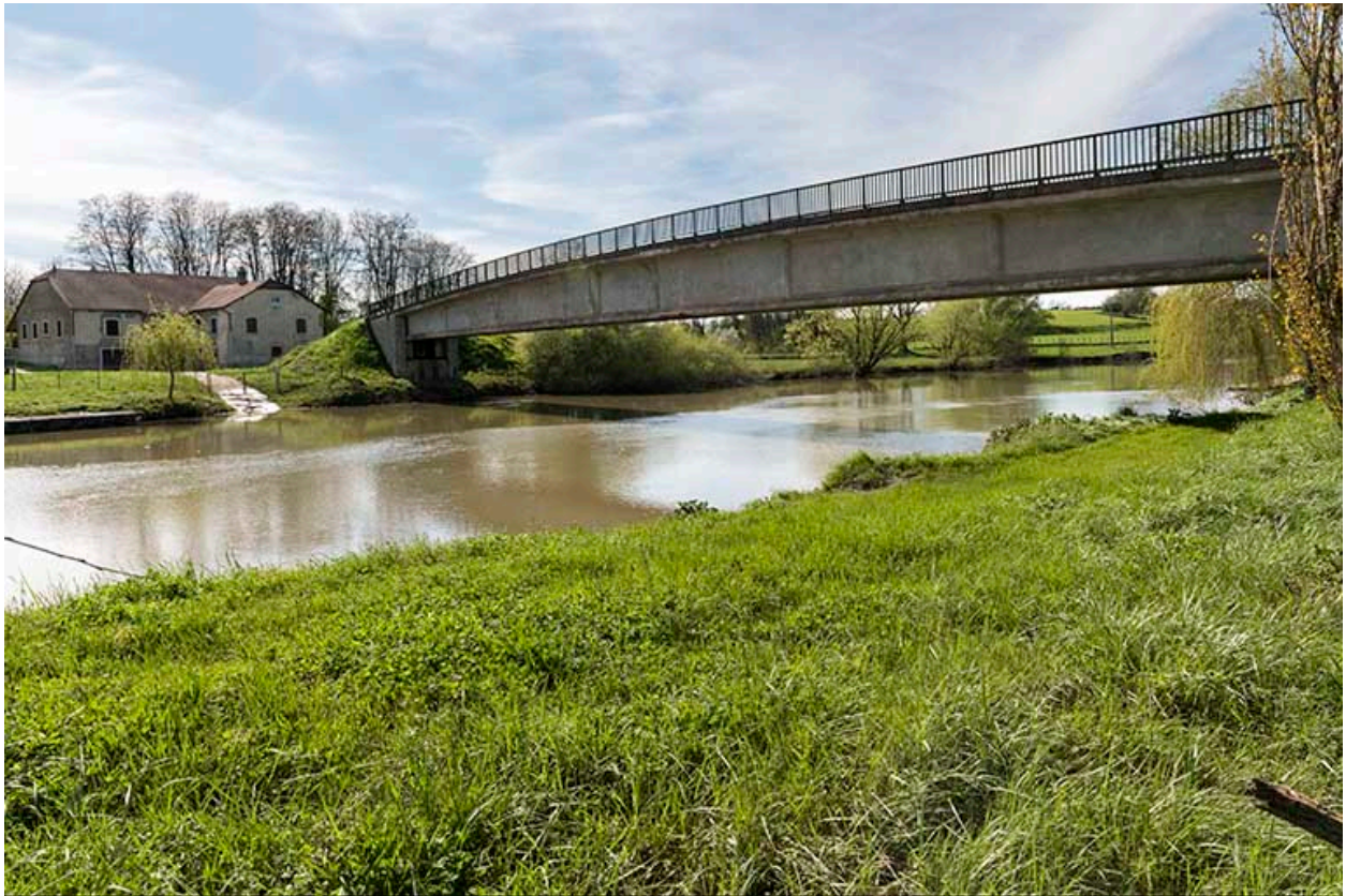
Franchissement de la Saône : pont de Fouchécourt.
